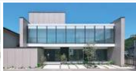
重量鉄骨造の住まい
